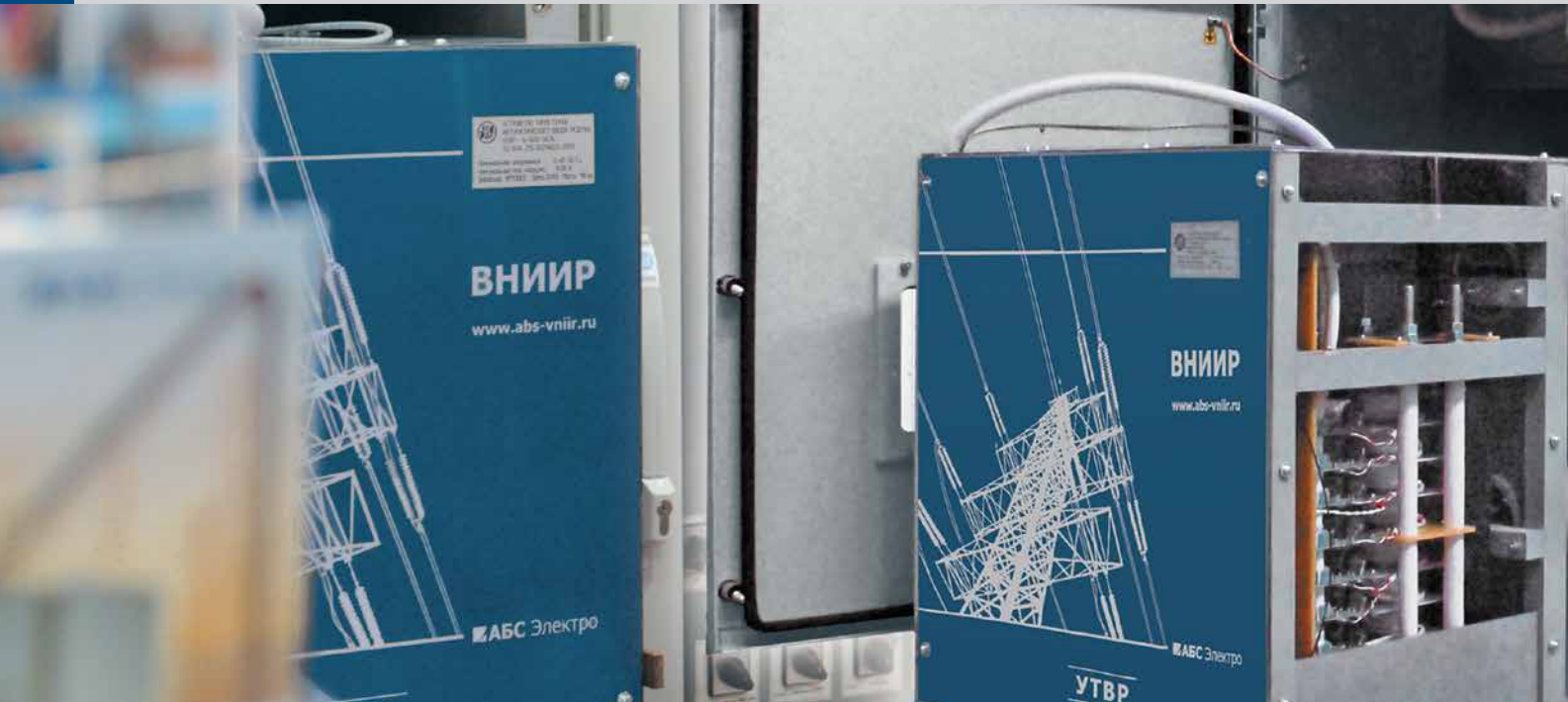
Тиристорные устройства АВР предназначены для автоматического быстродействующего переключения нагрузки аварийной секции сборных шин на резервный ввод
